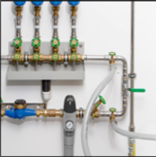
Lavado de instalaciones de agua potable con agua o mezcla de agua/aire, con aire comprimido intermitente 1)3)4)
