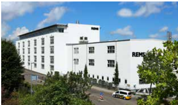
REMS Schulungszentrum in Waiblingen bei Stuttgart.
