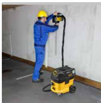
Zertifizierte Sauger und Entstauber zur Aufnahme gesundheitsgefährdender Stäube nach EN 60335-2-69.
